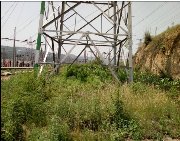
塔基恢复情况
