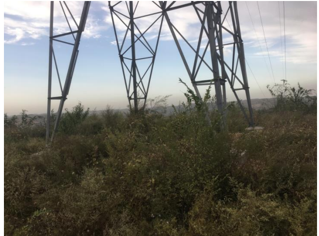
塔基恢复情况
