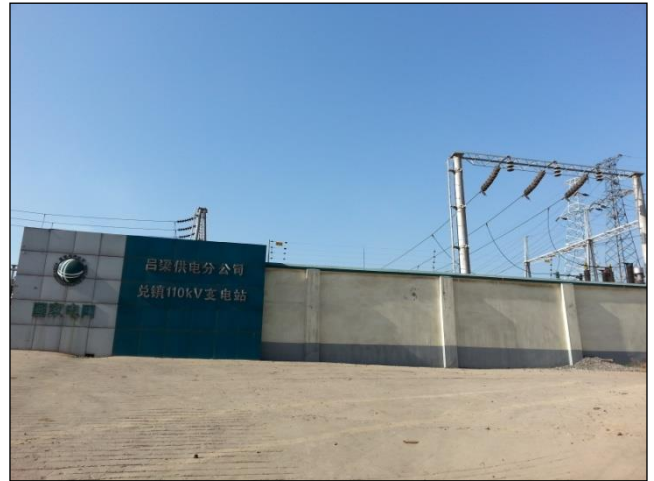
兑镇 110kV 变电站
