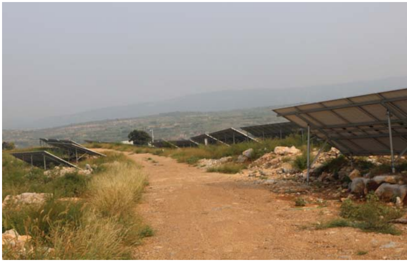
道路平整恢复
