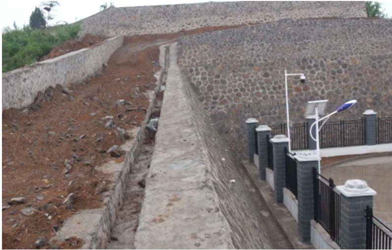
站外护坡和截水沟
