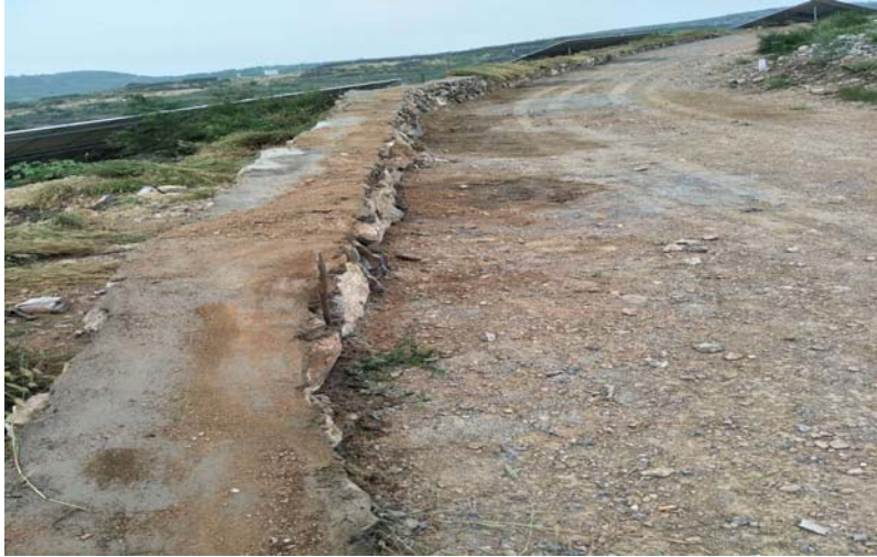
道路浆砌挡墙
