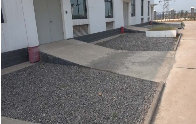
站内碎石铺设
