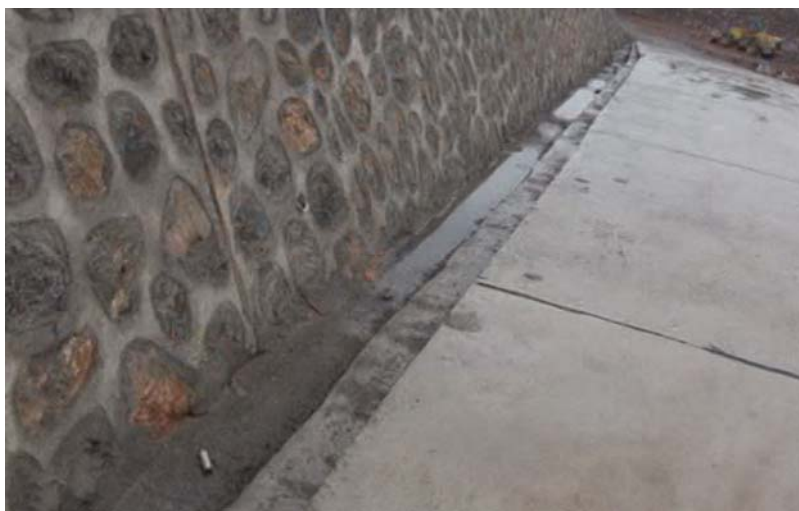
进站道路浆砌排水沟
