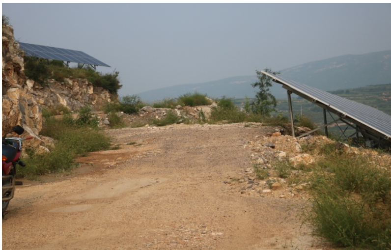
道路平整恢复
