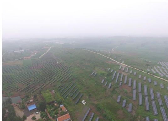
光伏板区现状
