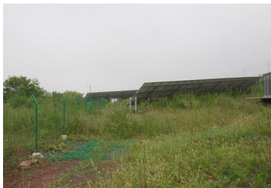
光伏组件区撒草绿化
