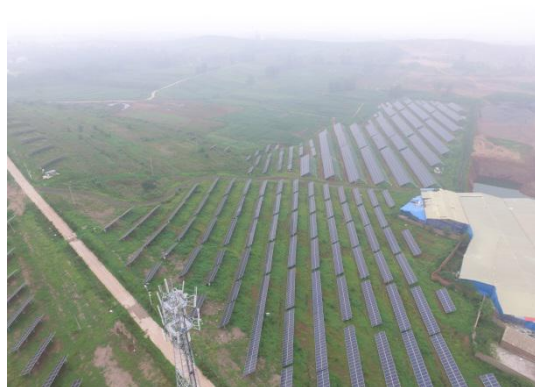
光伏板区现状
