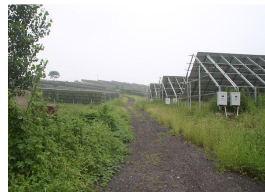
现场道路及绿化
