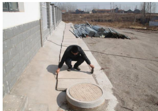
测量排水沟盖板
