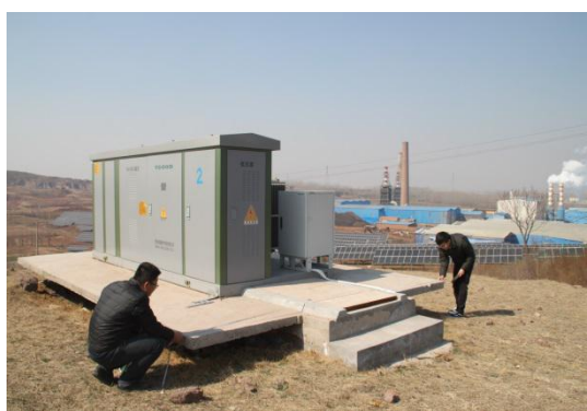
测量箱变基础
