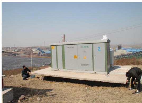
测量箱变基础
