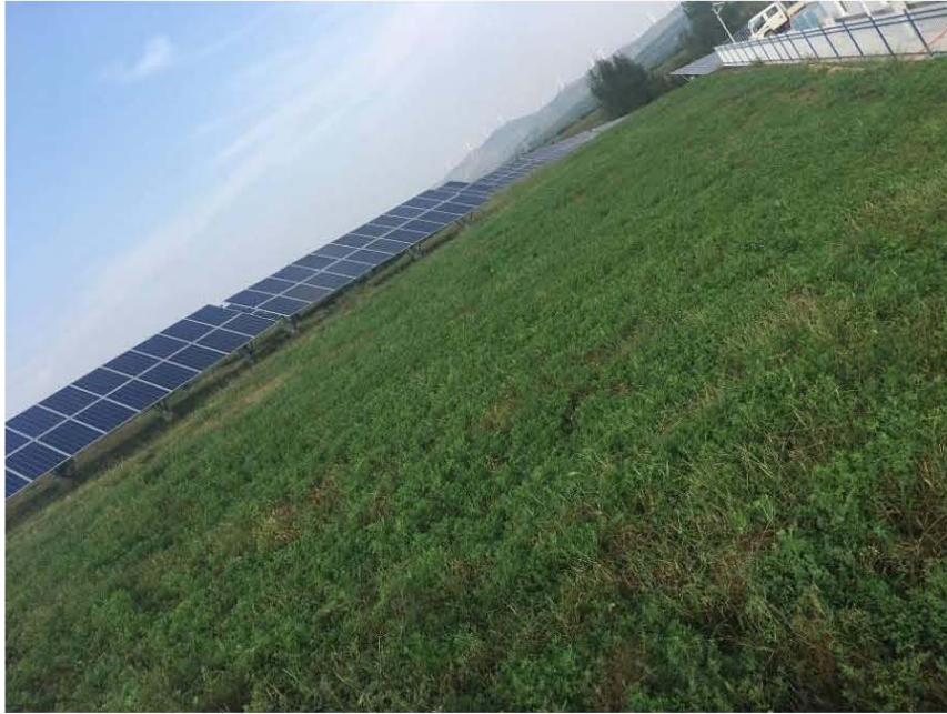
光伏厂区生态恢复情况良好，植被生长茂盛
