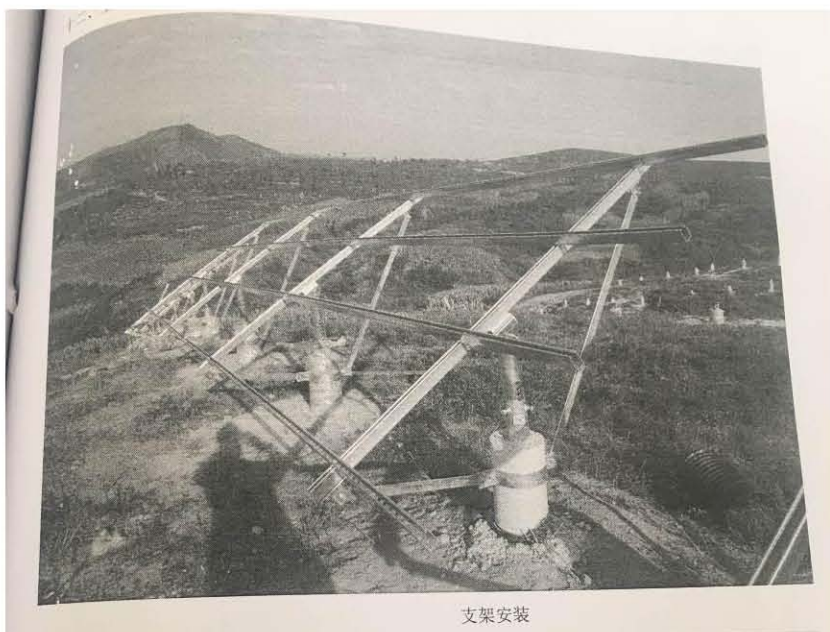
支架安装时有效控制占地面积减少对地表植被的扰动
