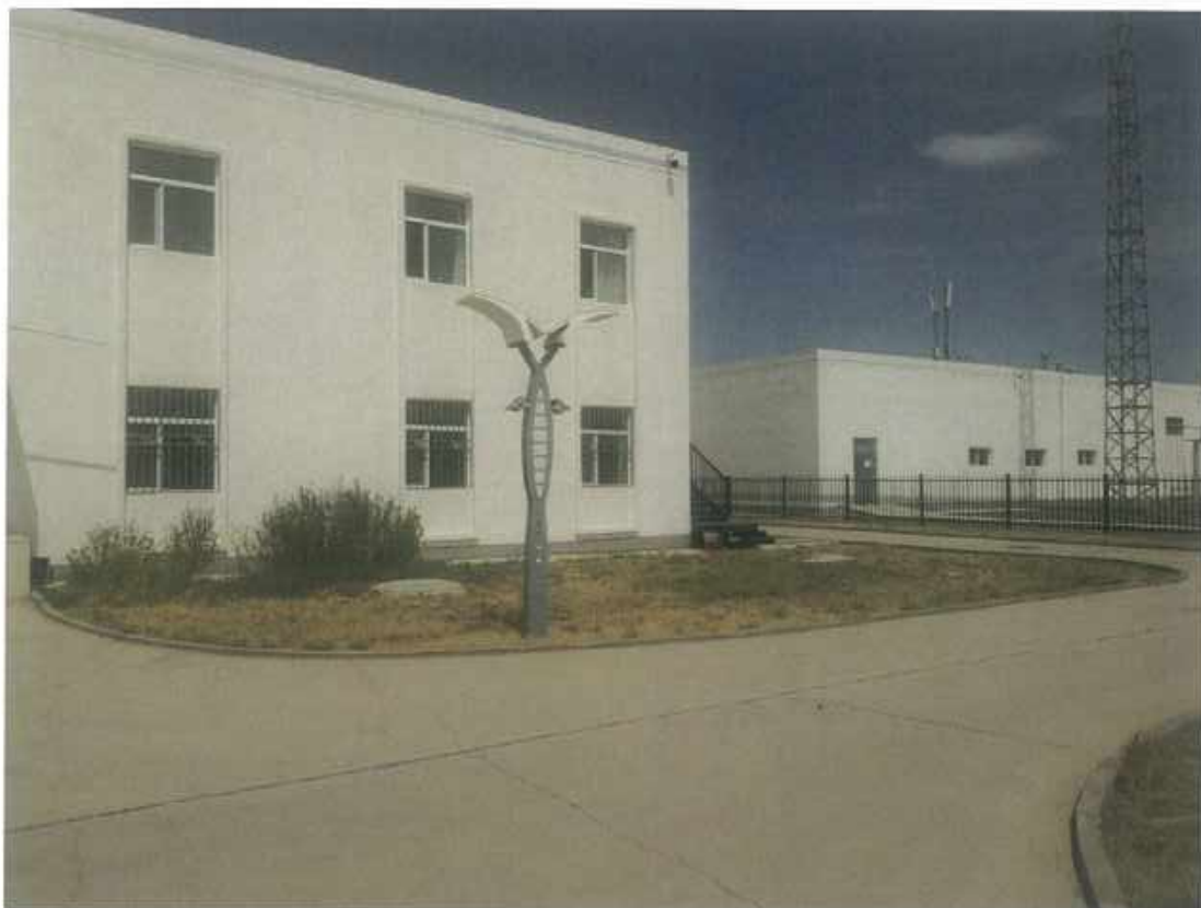
管理区硬化、砾石压盖、绿化 1
