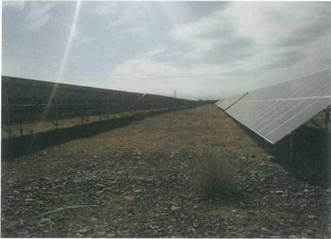
光伏系统区土地平整 1
