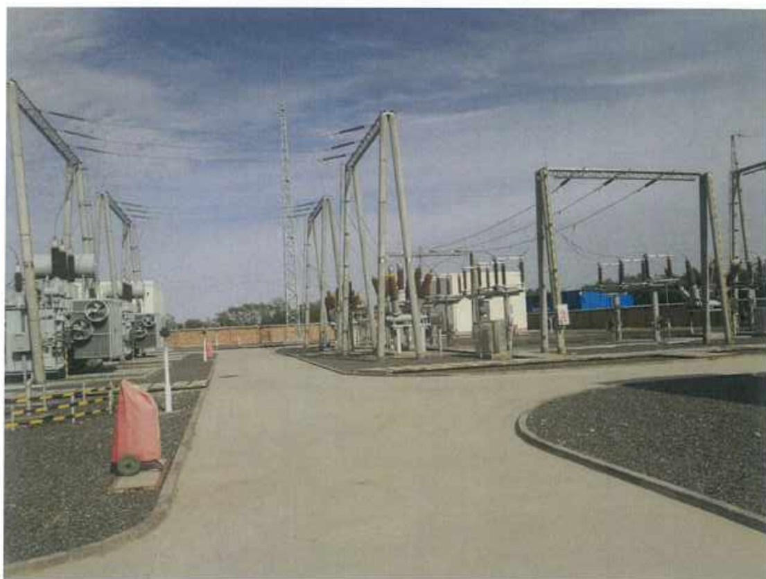
管理区硬化、砾石压盖、绿化 2
