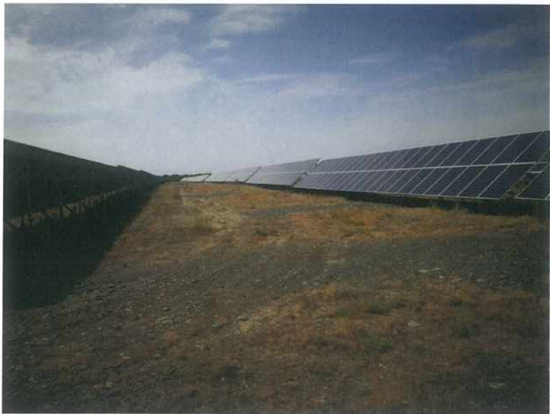
道路区土地平整与砾石压盖 2
