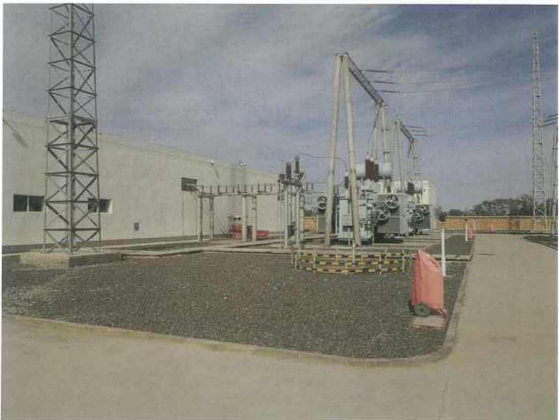
管理区硬化、砾石压盖、绿化 4
