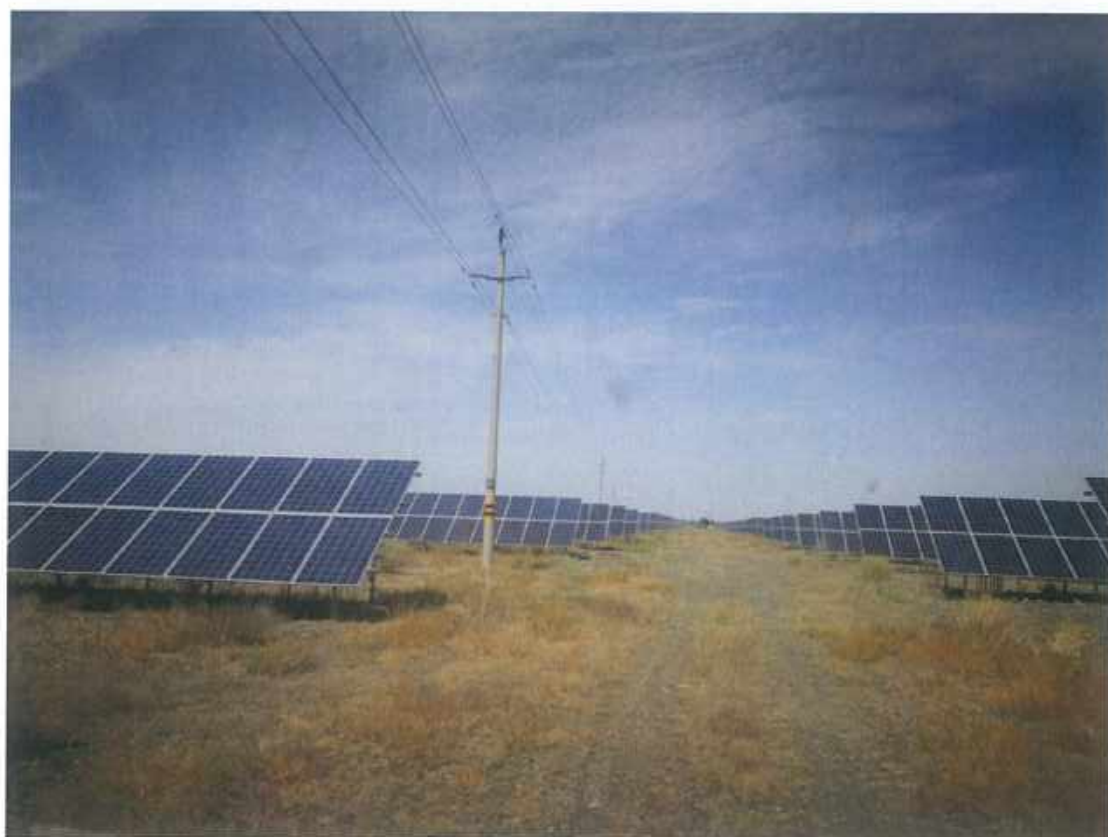
道路区土地平整与砾石压盖 4
