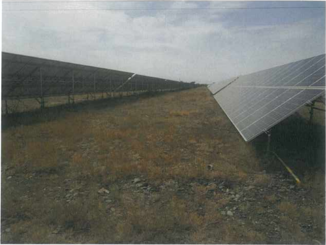
光伏系统区土地平整 3
