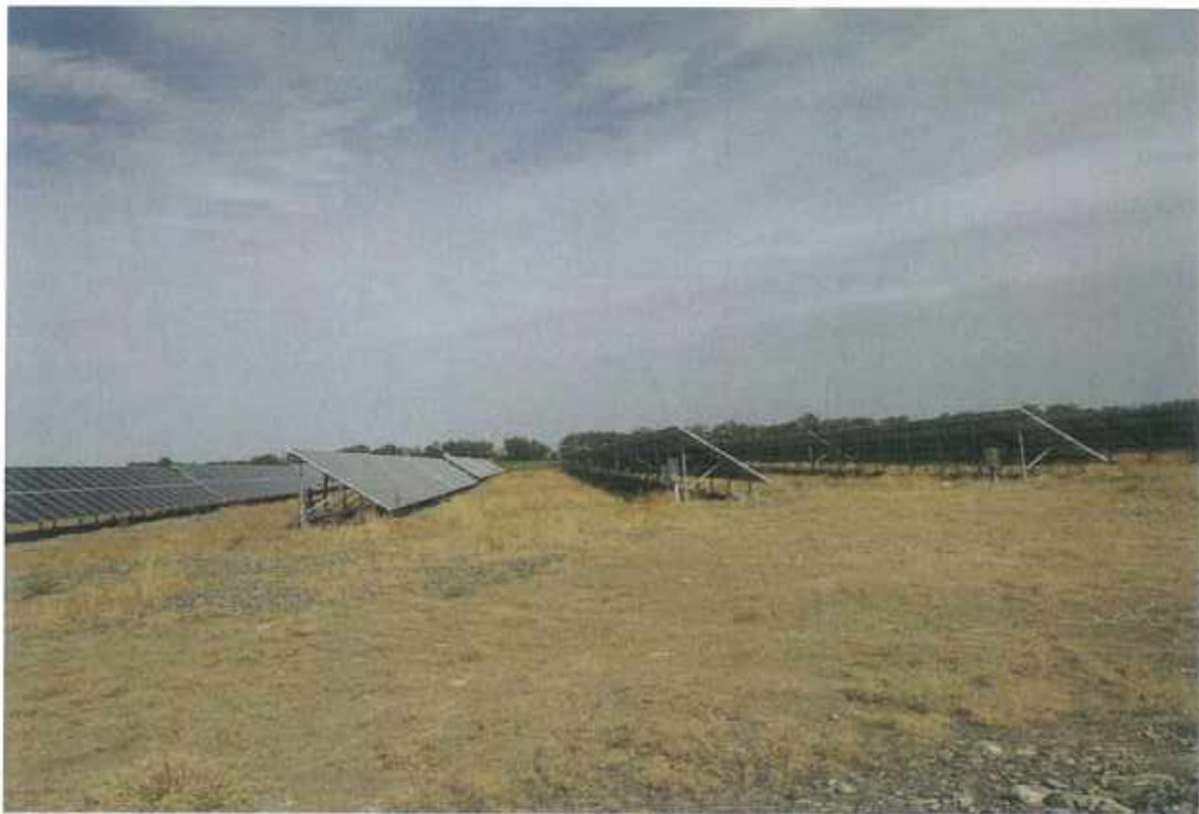
光伏系统区土地平整 2
