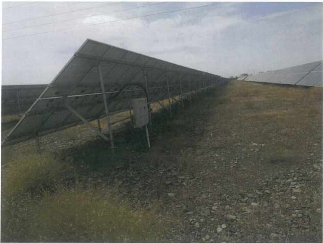
光伏系统区土地平整 4
