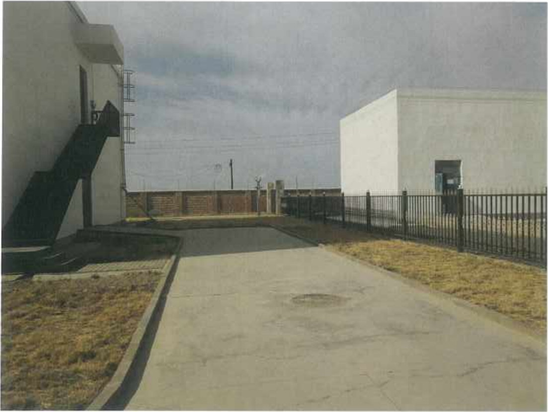
管理区硬化、砾石压盖、绿化 3
