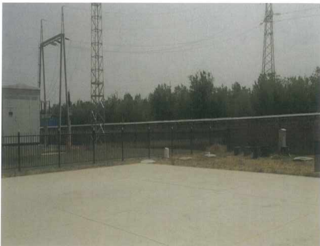
施工生产生活区土地平整与砾石压盖 3
