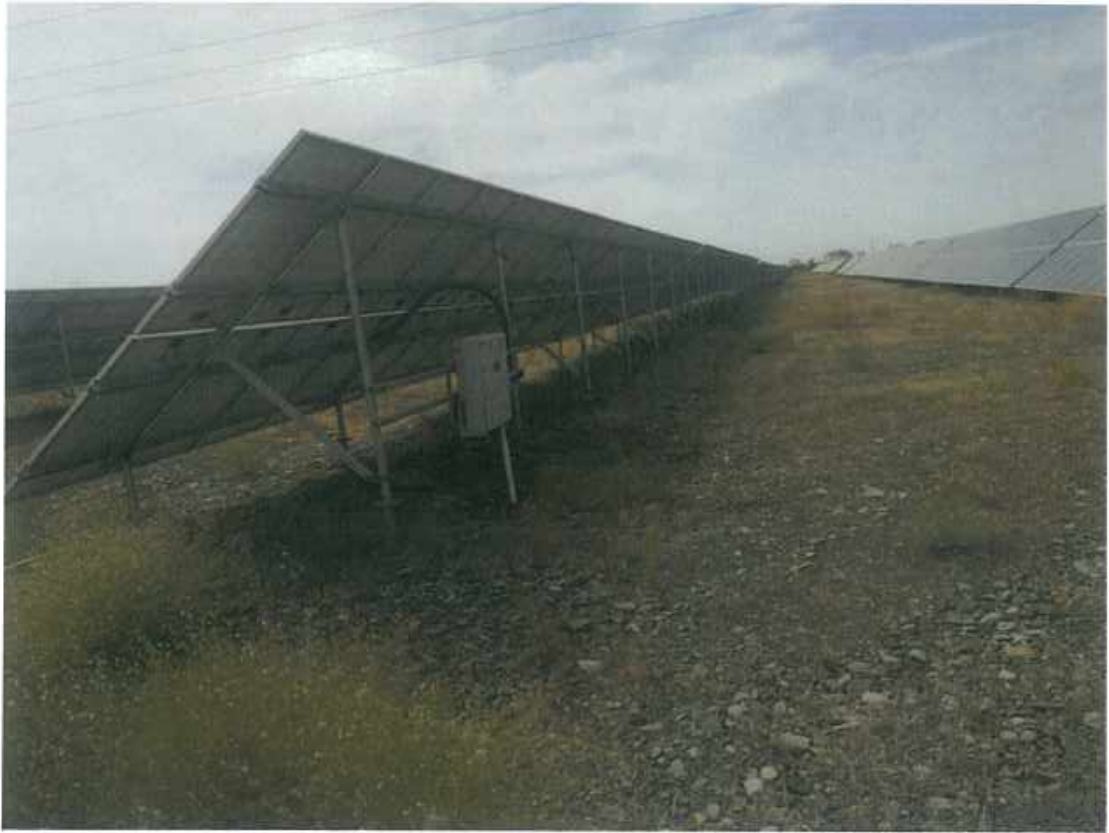
光伏系统区土地平整 4
