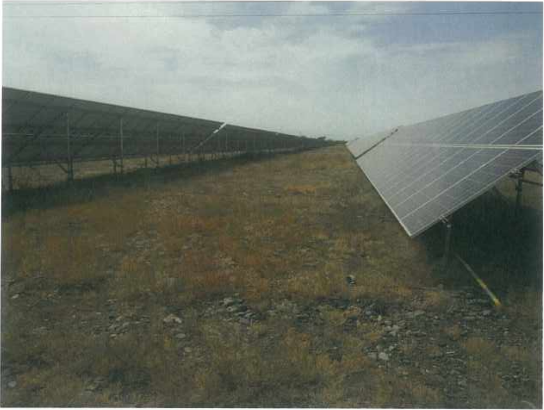
光伏系统区土地平整 3
