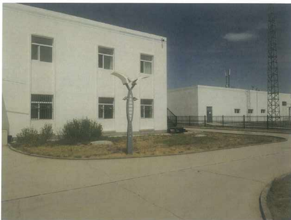
管理区硬化、砾石压盖、绿化 1
