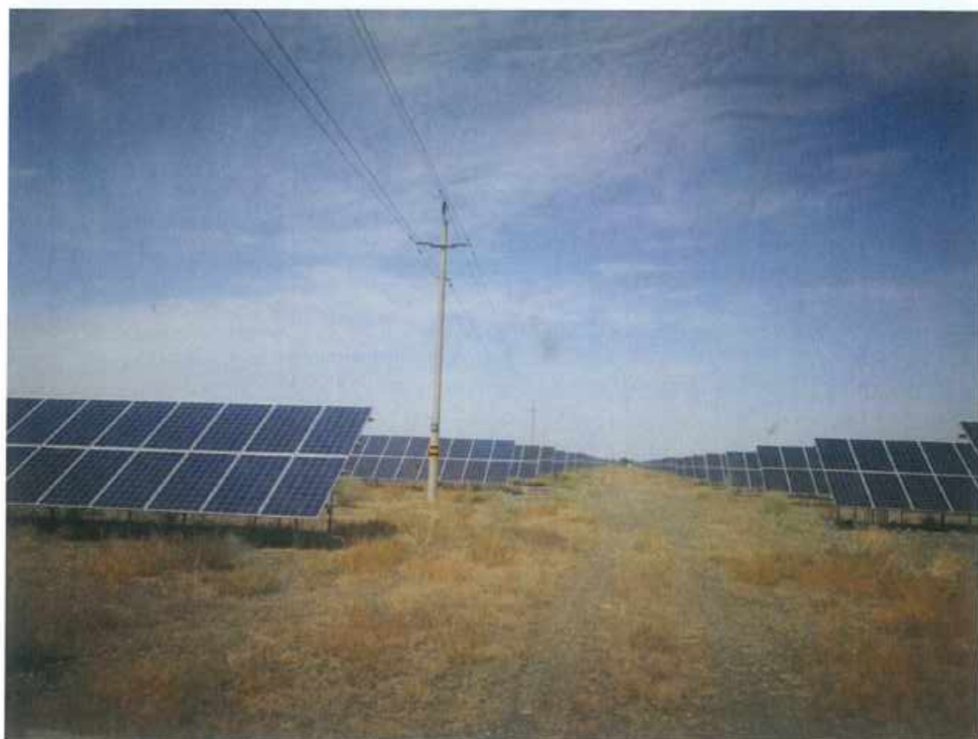
道路区土地平整与砾石压盖 4
