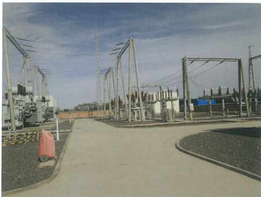
管理区硬化、砾石压盖、绿化 2
