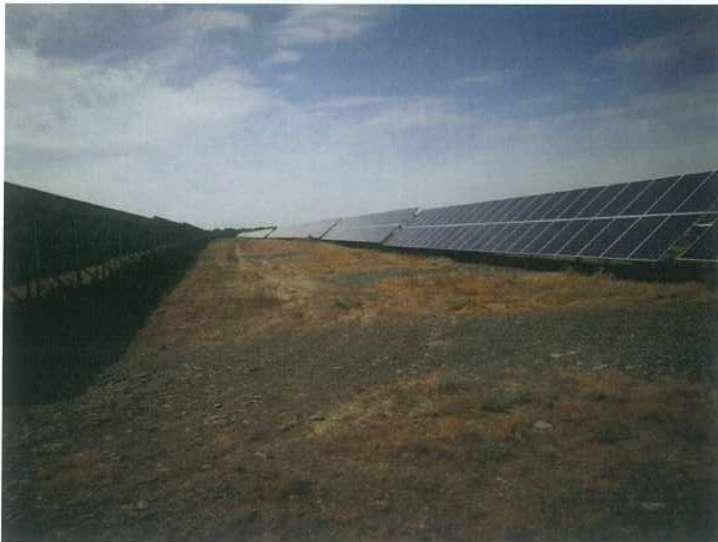
道路区土地平整与砾石压盖 2
