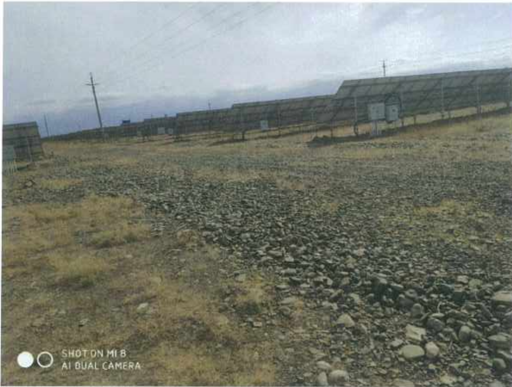
道路区土地平整与砾石压盖 1
