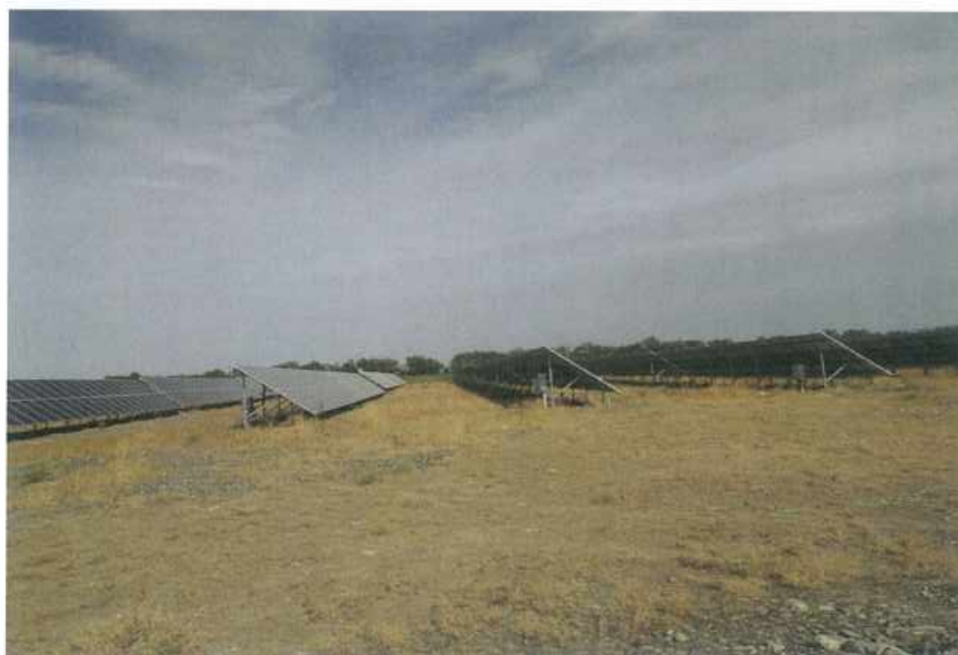
光伏系统区土地平整 2
