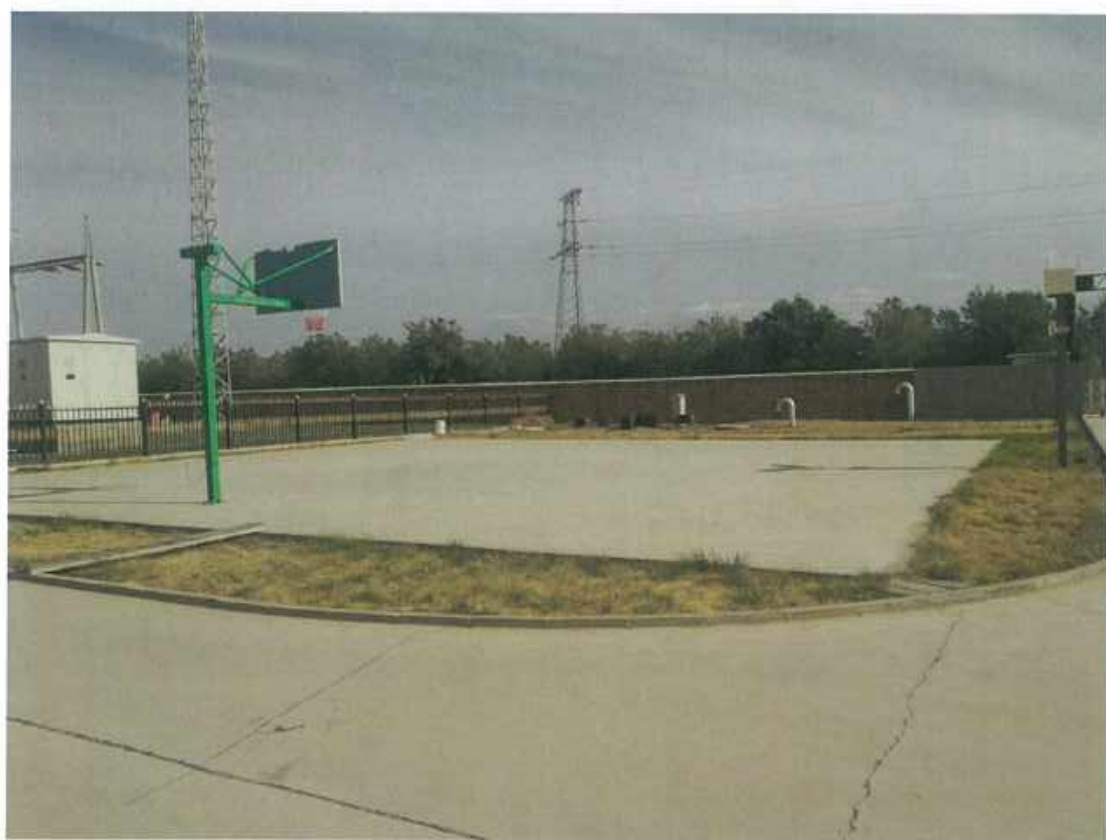
施工生产生活区土地平整与砾石压盖 2
