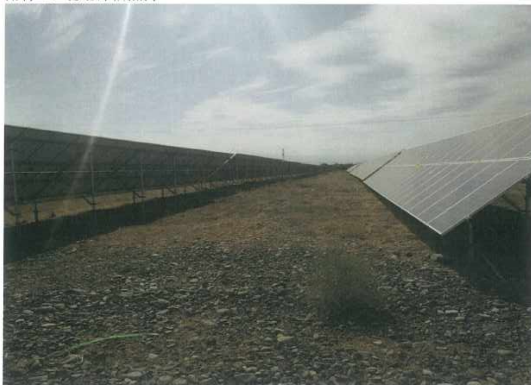
光伏系统区土地平整 1
