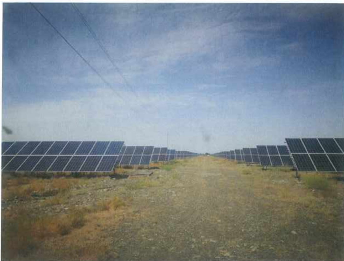
道路区土地平整与砾石压盖 3
