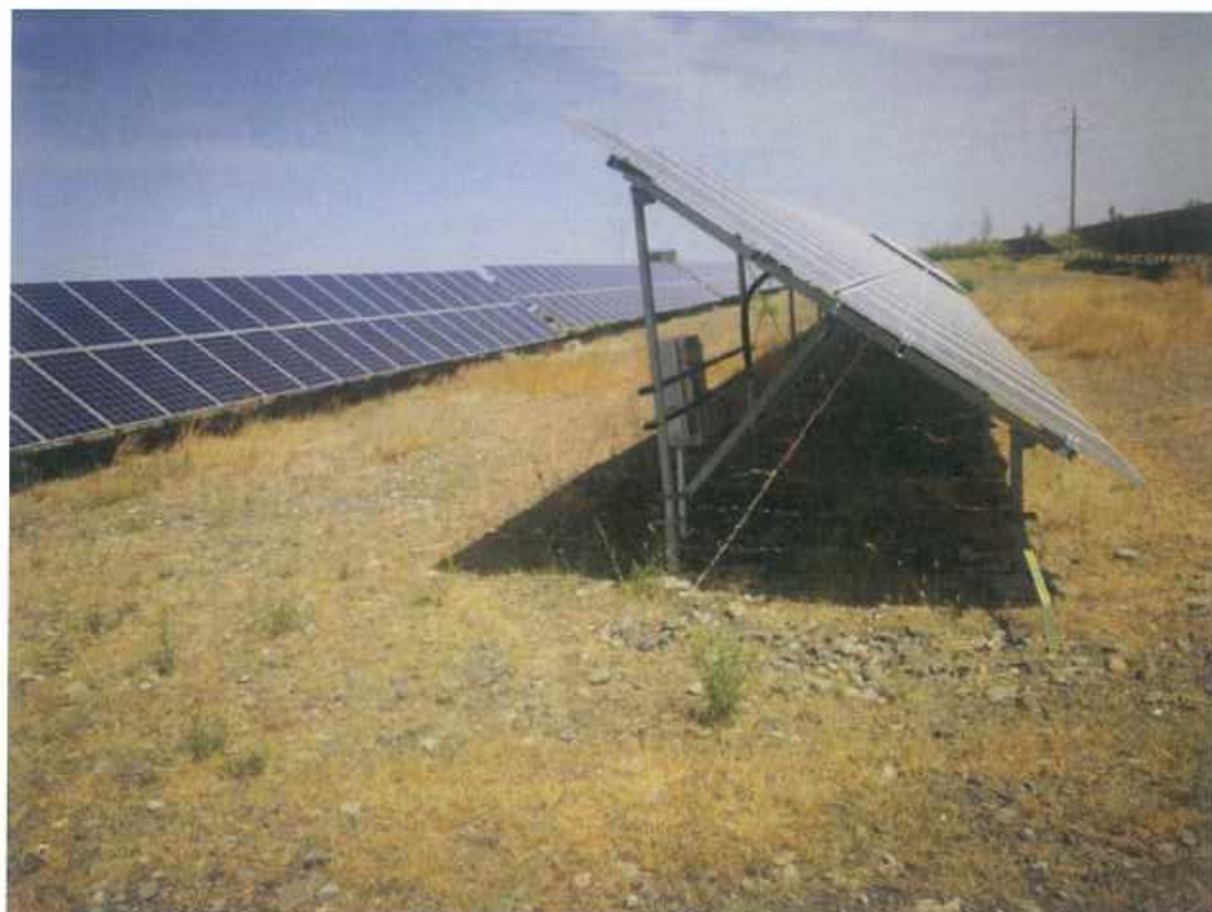
光伏系统区土地平整 4
