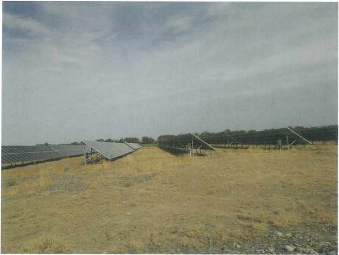
施工生产生活区土地平整与砾石压盖 1
