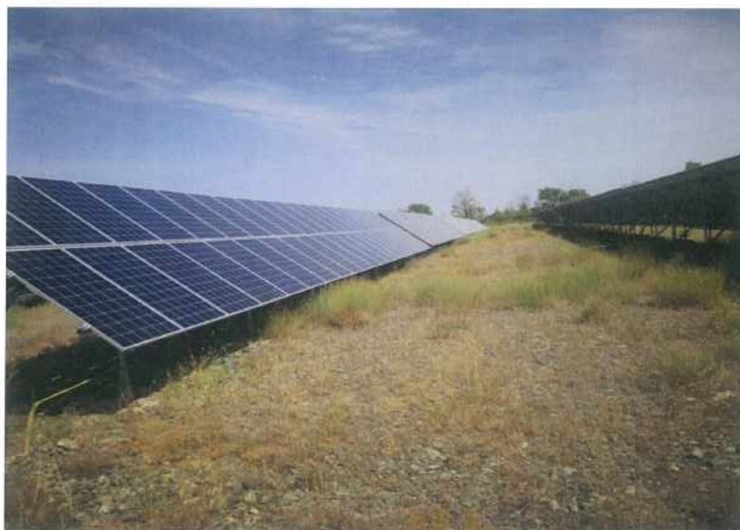
光伏系统区土地平整 2
