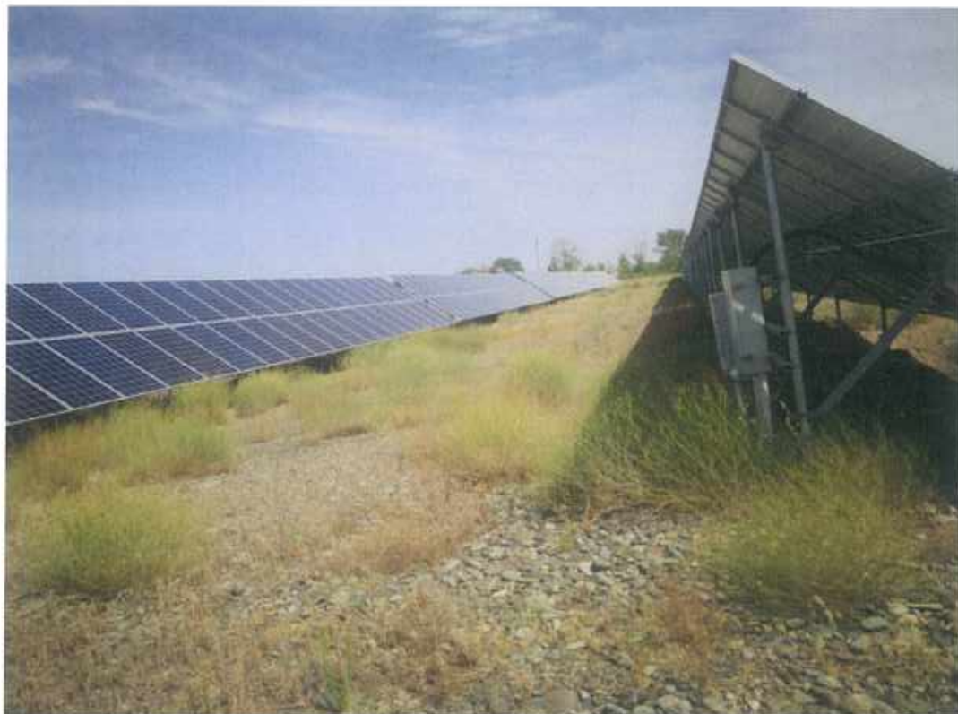
光伏系统区土地平整 1
