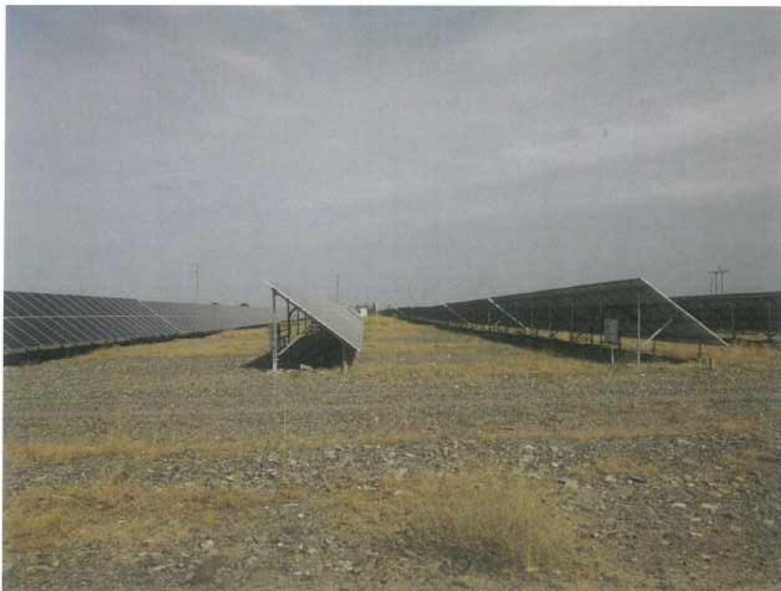
光伏系统区土地平整 3
