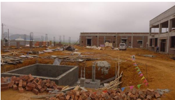
开关站施工现场
