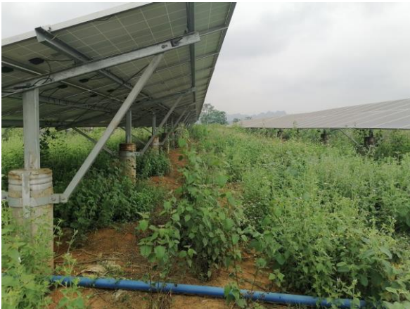
光伏阵列区后期植被恢复
