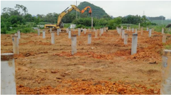
混凝土桩基安装
