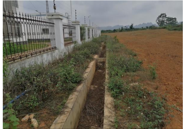
开关站浆砌石排水沟
