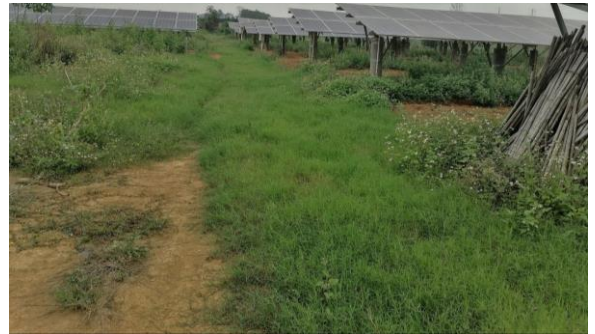
施工道路后期植被恢复
