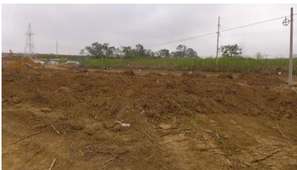
临时堆土场堆土
