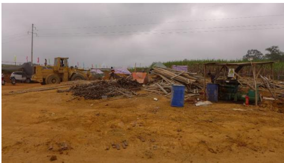
1#施工生产生活区施工期状况
