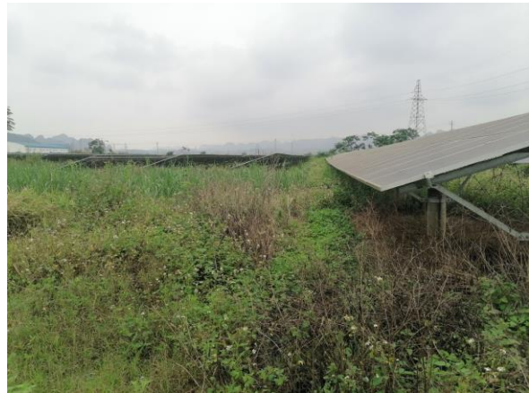
光伏阵列区后期植被恢复
