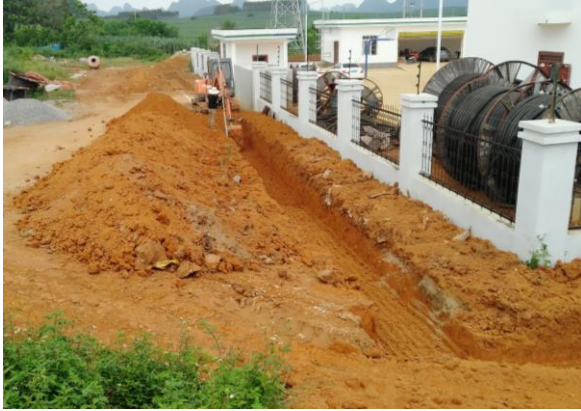
开关站外浆砌石排水沟开挖
