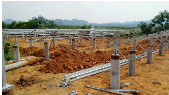
光伏支架安装
